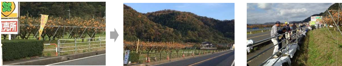
地域住民等によるガードパイプの塗装 (八頭町大門地区)
